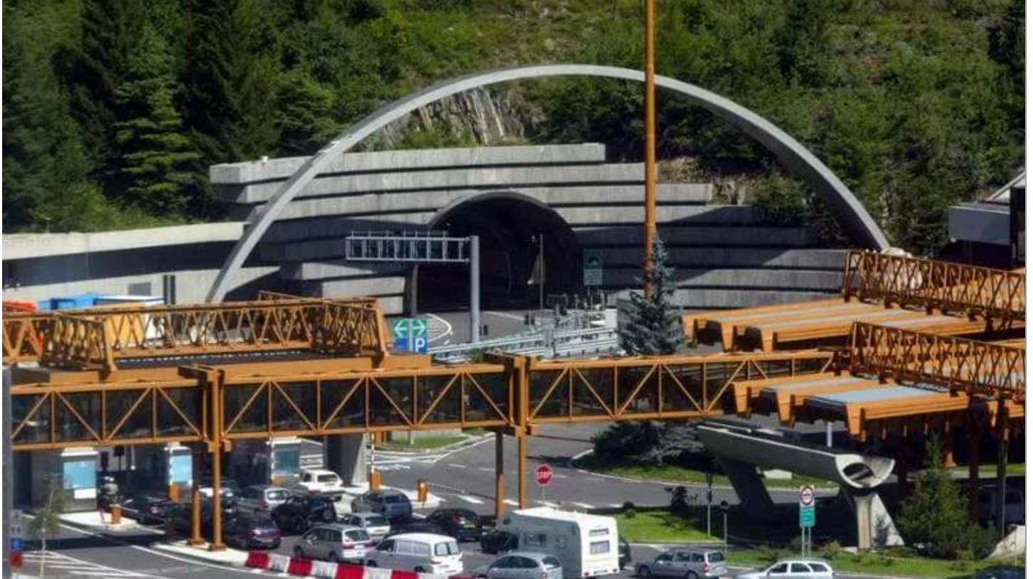
L'ingresso del traforo del Monte Bianco dal versante italiano
