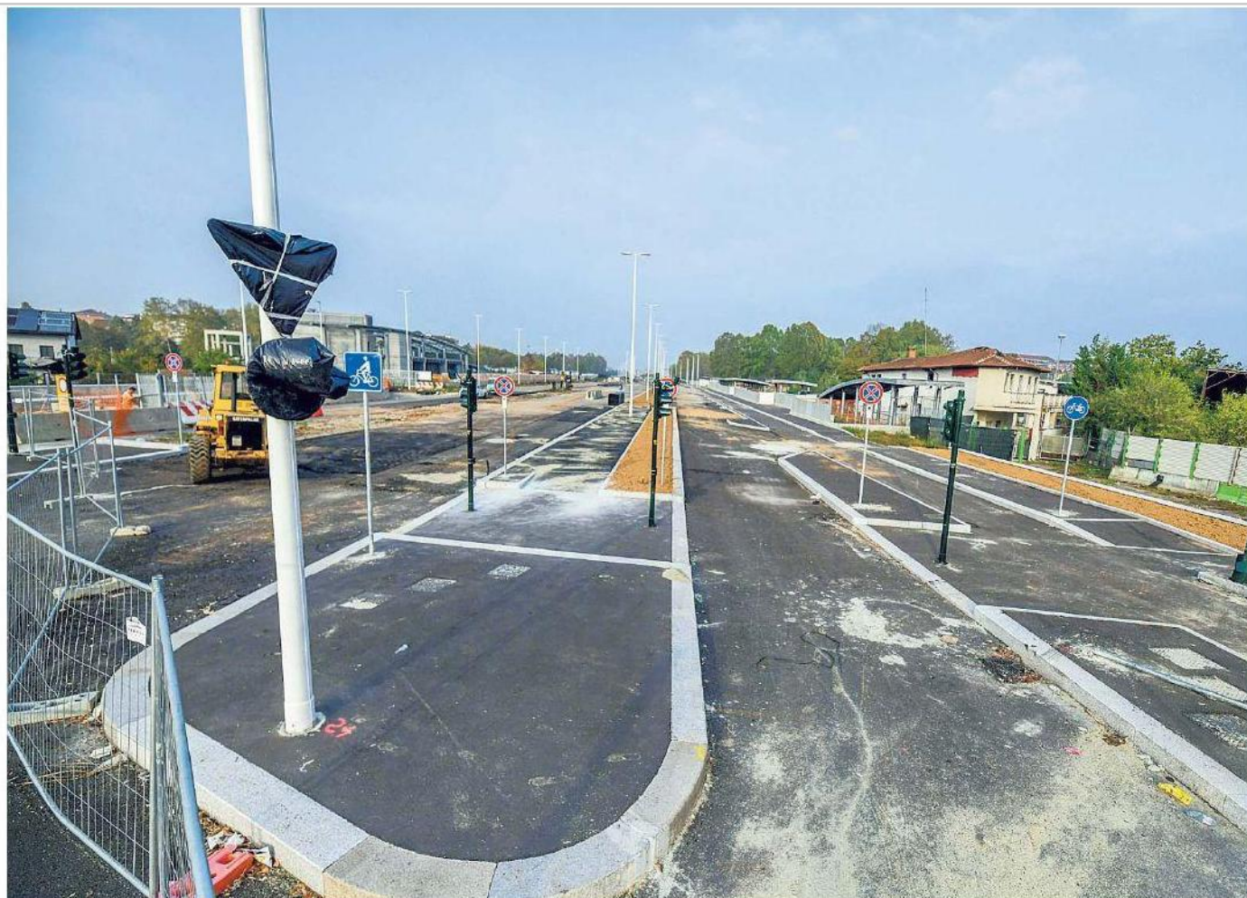
I lavori fermi all'altezza dell'ultimo tratto di corso Venezia
