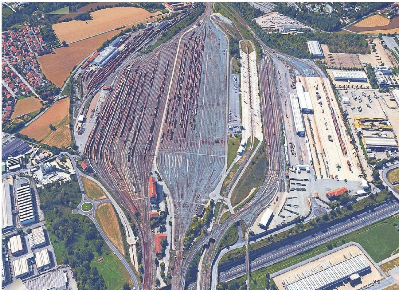
Il collegamento tra Avigliana e lo scalo merci di Orbassano dovrebbe essere al centro del confronto con le amministrazioni locali
