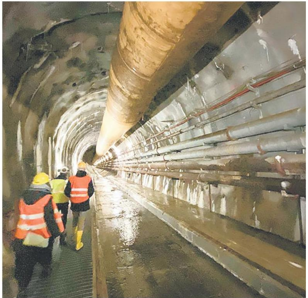
Il cantiere Tav di Chiomonte ha ripreso a lavorare nei mesi scorsi
