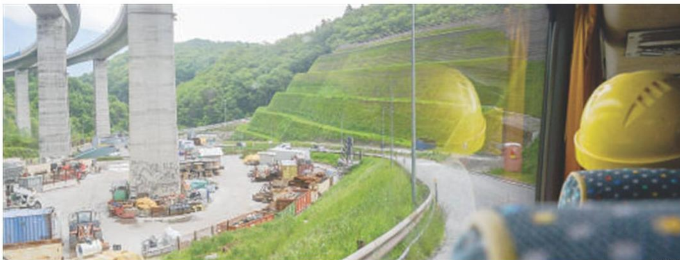
Il cantiere dell'Alta velocità di Chiomonte
