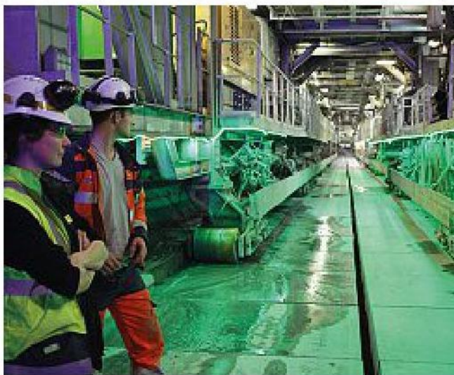
Versante francese Il cantiere della Tav visto dalla Francia
