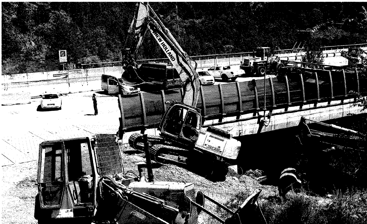
ALL'OPERA Una veduta del cantiere Tav di Chiomonte ieri dopo l'avvio delle attività seguito all'intervento delle forze dell'ordine per rimuovere i presidi dei No Tav; sono 150 gli addetti impegnati nelle operazioni per la galleria
