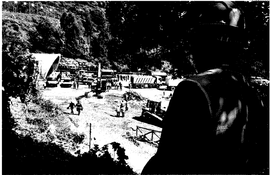
Al lavoro. Il cantiere di Chiomonte propedeutico allo scavo del tunnel geognostico della Maddalena
