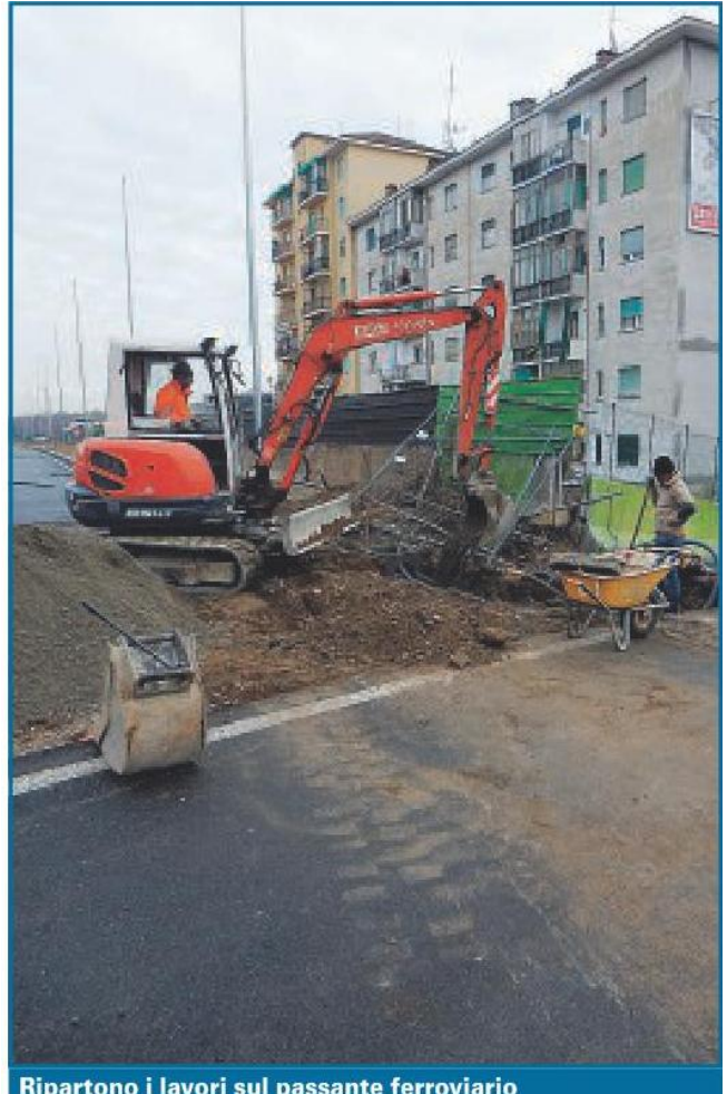
Ripartono i lavori sul passante ferroviario
